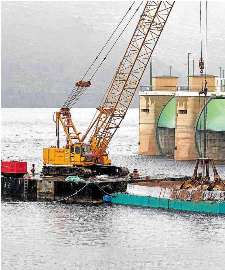
Trabajos de recuperación en la presa de Forata en una imagen de archivo. IVÁN ARLANDIS
